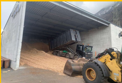
Silo ouvert, d'une capacité de 1'200 m 3 de plaquettes.
