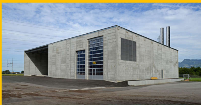
Bâtiment abritant , sur la gauche le silo ouvert et sur la droite les quatre chaudières alimentant le réseau.
